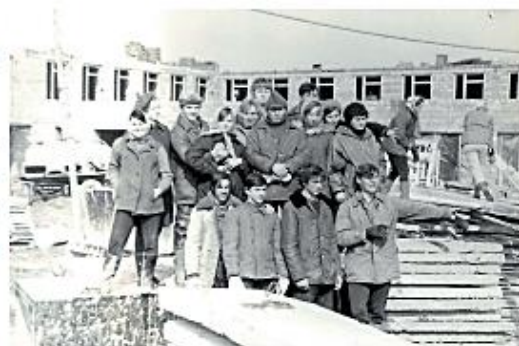
Школьники помогают в строительстве новой школы, 1973 год
