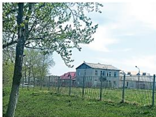
Здание, в котором находилась амбулатория с 1982 до 2017 года
